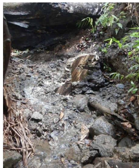
... Et après intervention
